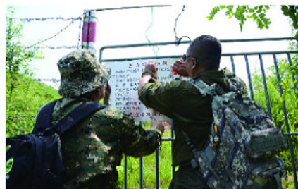
志愿者在固定铁丝网栅栏上安装警示牌匾
