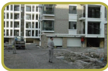
在新建房屋地基上喷洒氯丹
