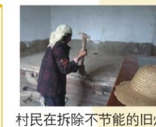
村民在拆除不节能的旧炕
