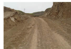
修好的通社道路 Built road
