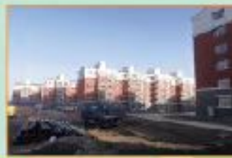
曲长城村新建住宅楼
