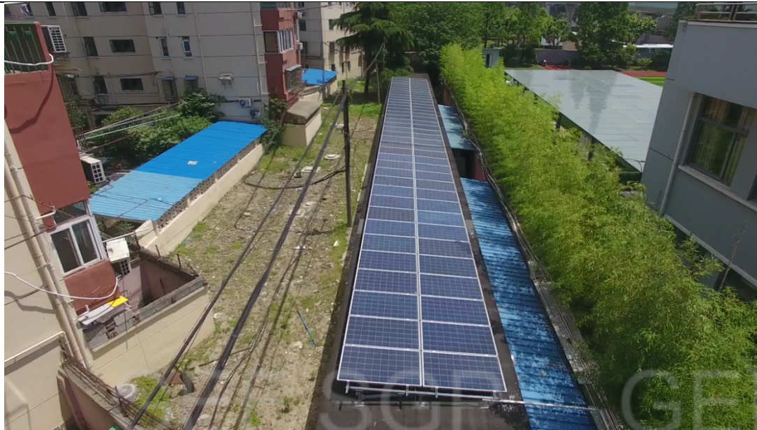
已安装光伏的航拍图
