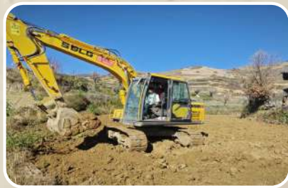
(松坪*深翻土地的挖掘机)
